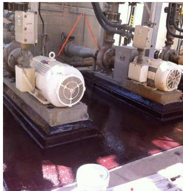
轻松刷涂施工保护各种几何形状免受化学侵害
