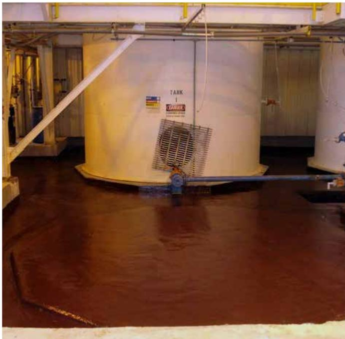
贝尔佐纳(Belzona) 4311 (乳浆 CR1) 是一种可手动敷涂和喷涂的双组分防护涂层, 用于为表面提供防化学侵害保护。
