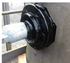
变压器泄漏密封
